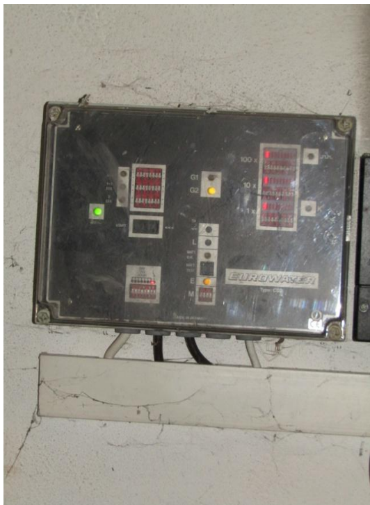
fot. 10 system sterowania elektrycznego i pracy stacji uzdatniania wody
